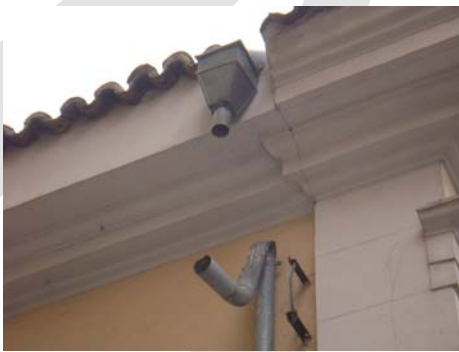
Detalles del canalón situado junto a la sala del museo nº 10, antes y después de su reparación.
